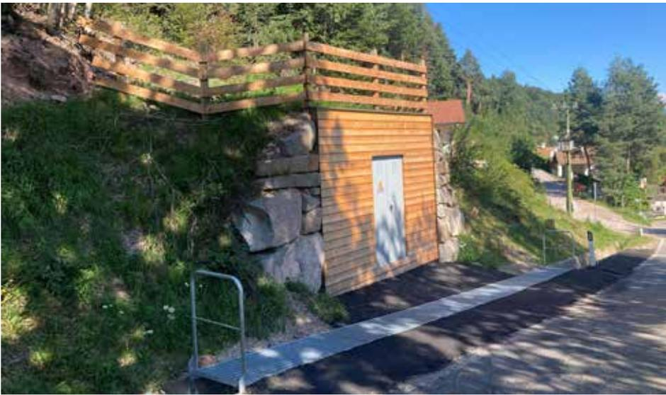
Die E-Kabine in Glaning ist fertiggestellt und ermöglicht nun die Erdverlegung der Mittelstrom-Leitung.
